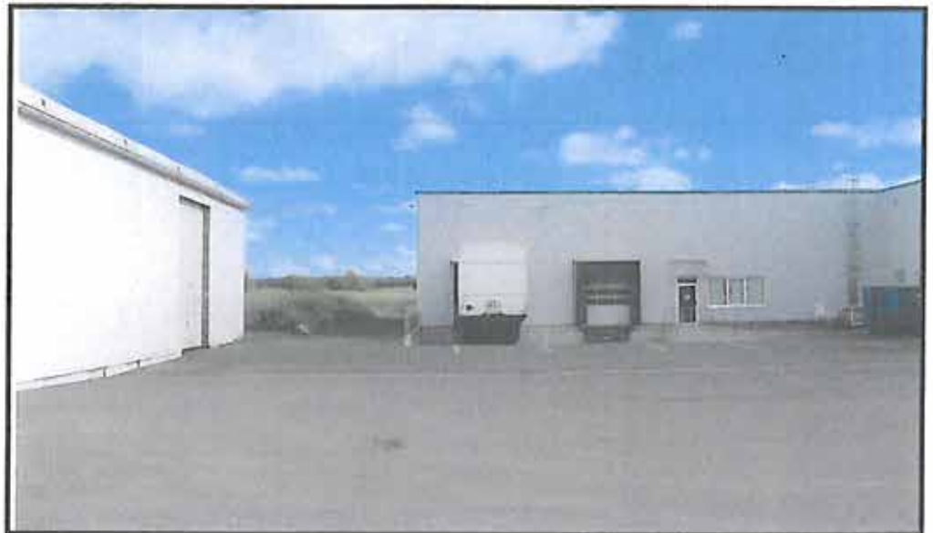
Anlage zur WE 13.09.2005: Lite-Licht GmbH, Betriebsgebäude, Hörsinger Weg 9, 39343 Bartensleben
